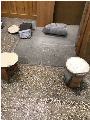
Kernbohrungen Bruchsteinmauerwerk, Backsteinmauerwerk
