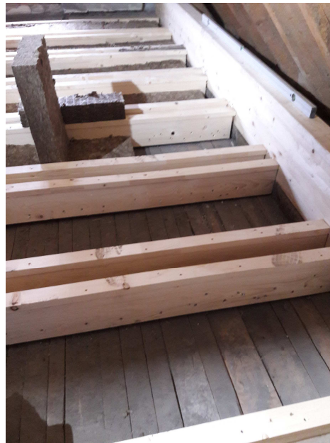
Verstärkung der Balkenlage, Zentrieren der Auflagerkräfte DG
