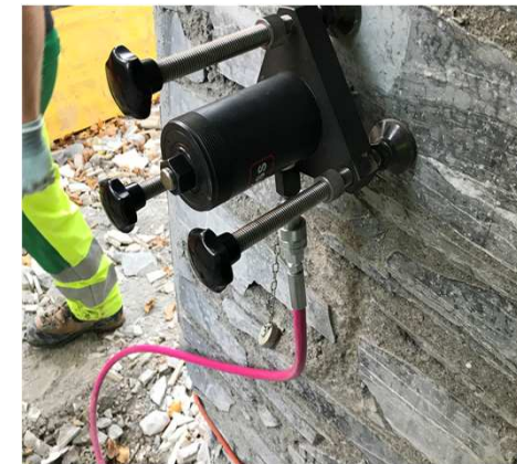
Ausziehversuche Bruchstein- mauerwerk versagen heraus- ziehen der Ankerstange bei 36kN, d=12mm Backsteinmauerwerk geringe Aussagekraft, Versagen bei ca. 30kN, d=12mm
