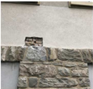
Übergang Bruchstein-, Backsteinwand
